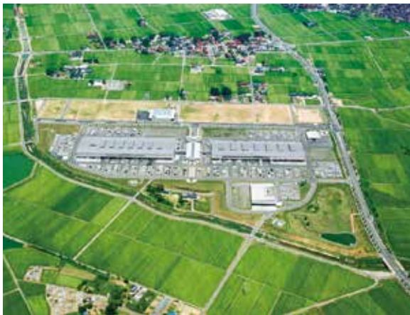
郡山市総合地方卸売市場
