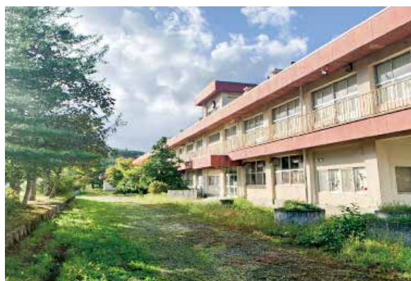
廃校となった旧福良小学校
