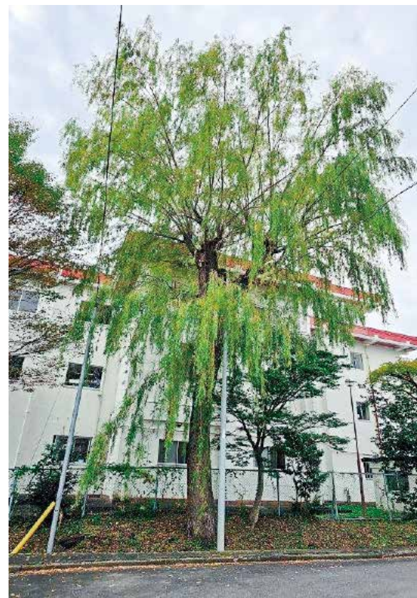
行健小学校の通学路にある電線と接触している大木
